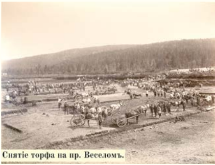
Снятие торфа на пр. Веселомъ.
