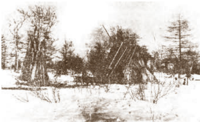
Удэхайская юрта в виде двускатной крыши, сделанной из елового корья
