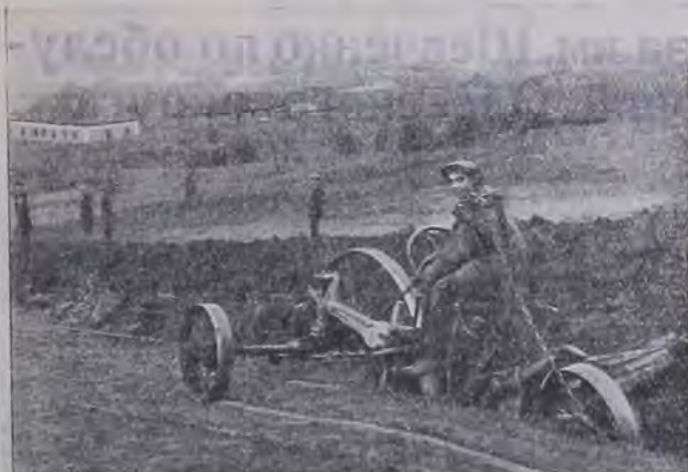
Поднятие перевальным плугом глубокого пере- вала под виноградники.
