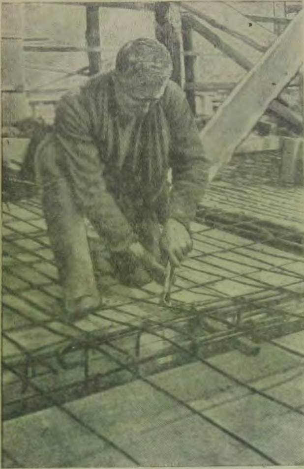
Еврейская автономная область На сн.: стахановец Обзorstroy т. Бычков скрепляет бетонное перекрытие (Фото Х. Гринберга)
